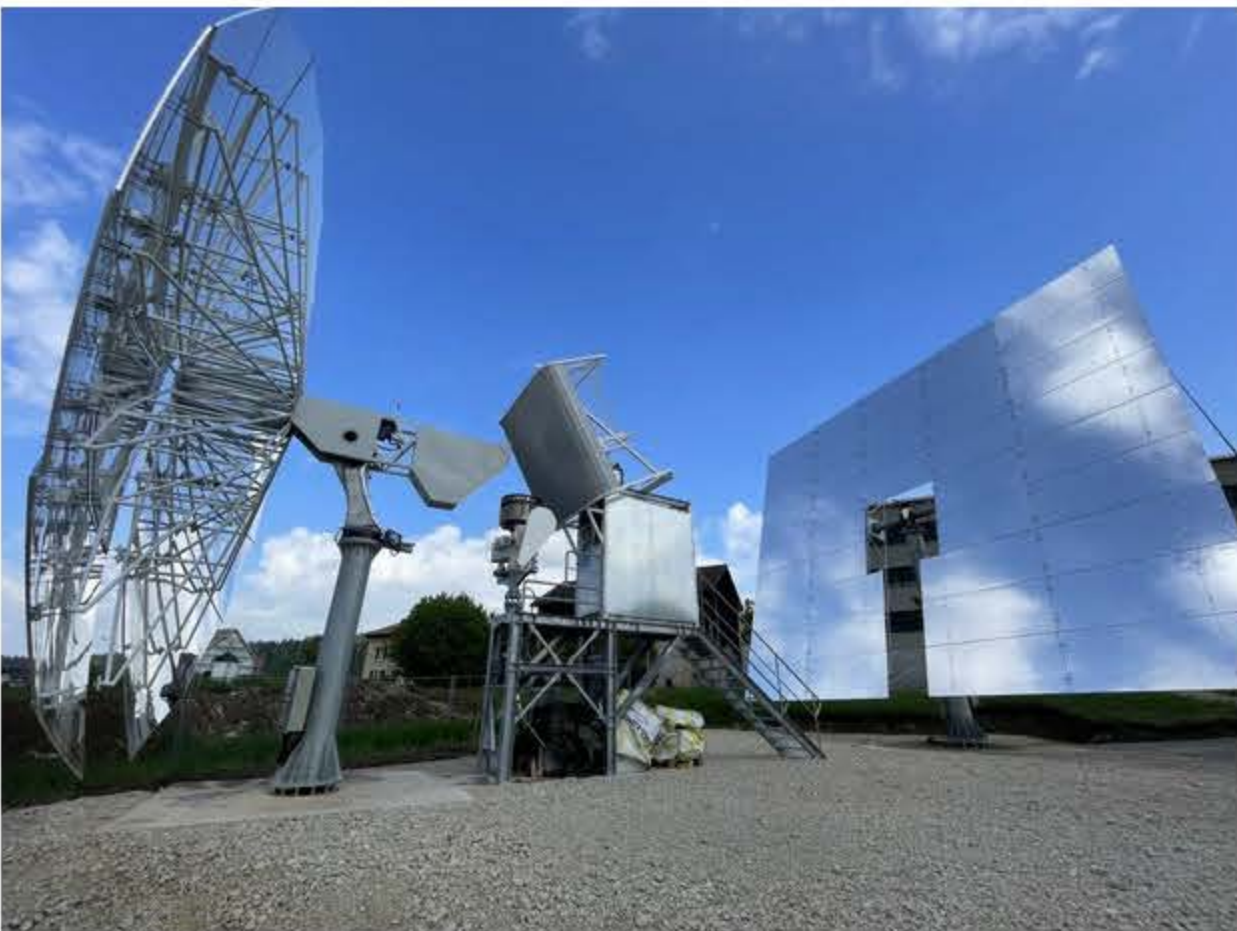
À droite, l'héliostat de 138 m² capte les rayons du soleil et les renvoie vers le concentrateur à gauche, qui concentre la lumière à la manière d'une loupe et la dirige vers un réacteur solaire placé en contrebas. Crédit photo PANATERE.
